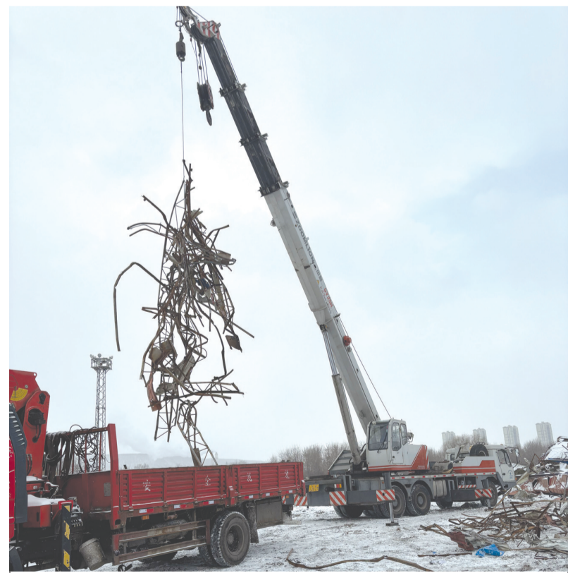
鞍钢股份设备器材采购中心物流仓储党支部充分发挥战斗堡垒作用,通过开展“战危机、勇挑战、做贡献”主题实践活动,组织党员深入作业现场,全力回收废钢铁,为打赢降本增效攻坚战作出贡献。图为该党支部组织党员进行吊装废钢铁作业。 通讯员 孟凡涛 摄
