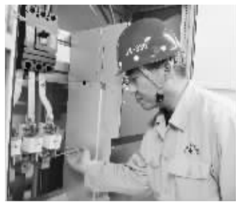
王宇在测试高压断路器。
