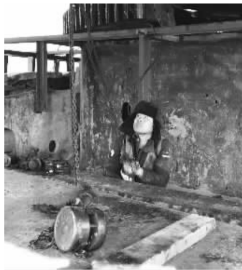
张玉坤在采场进行检修作业。
