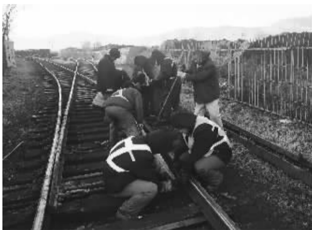
友们正在更换铁轨。 马忠利(拿撬棍者)和工
