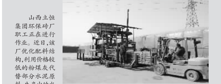
山西立恒集团环保砖厂职工正在进行作业。近日,该厂优化配料结构,利用价格较低的粉煤灰代替部分水泥原料,生产出的水泥砖不仅可满足强度要求,还使每块砖成本降低了近1分钱,预计每月可降低成本3万余元。
