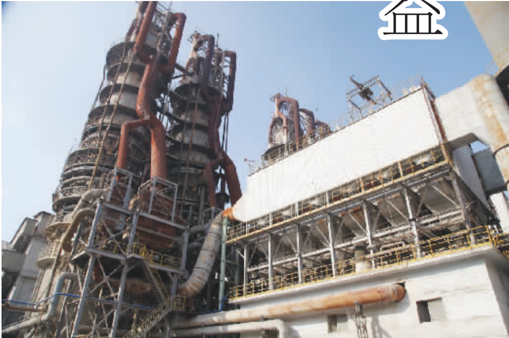
气烧竖窑——用于生产炼铁用石灰。
